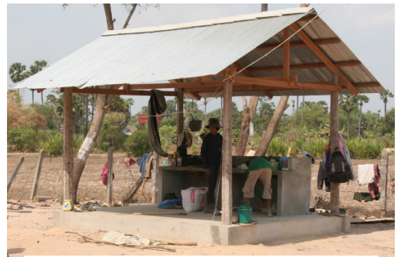
Die Patienten-Küche ist gerade fertiggestellt worden.
